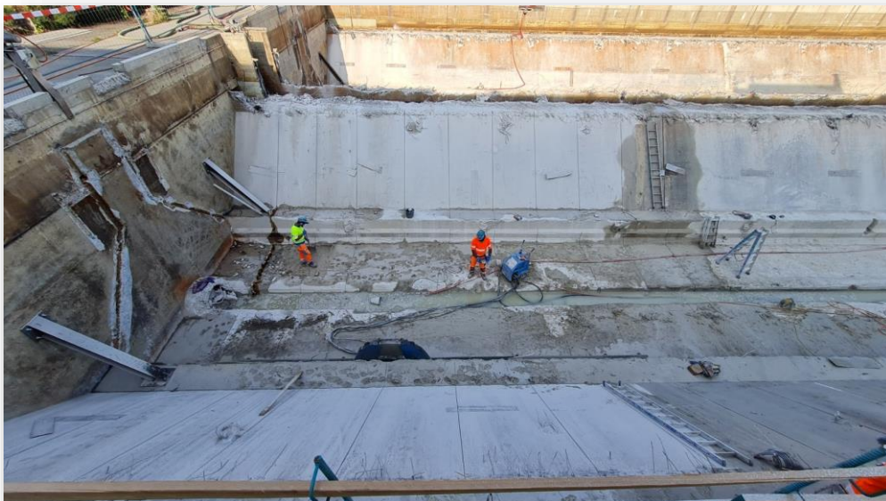
Sciage des bases d'ouvrage.
