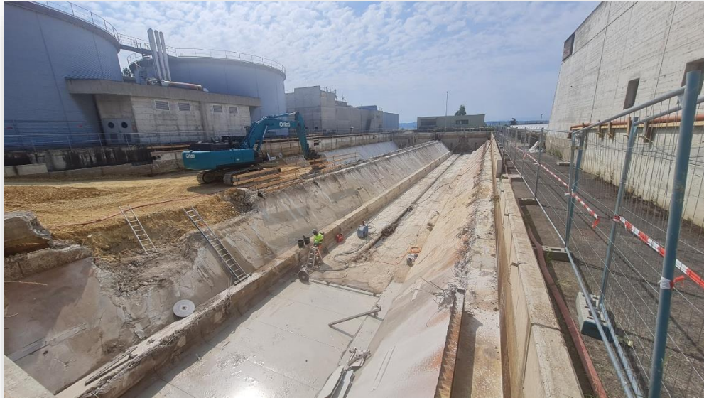
Sciage des bases d'ouvrage.
